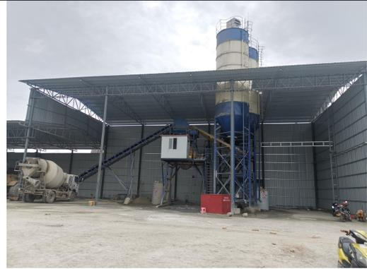
料仓（水泥、粉煤灰）、外加剂储罐
