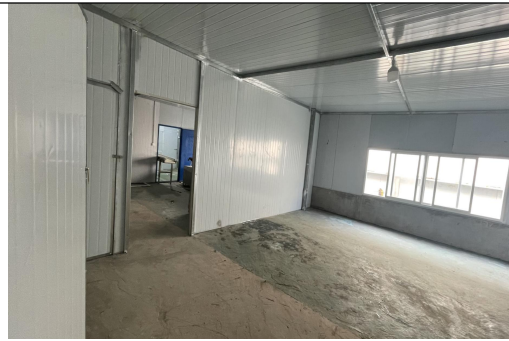
封闭生产区现状
