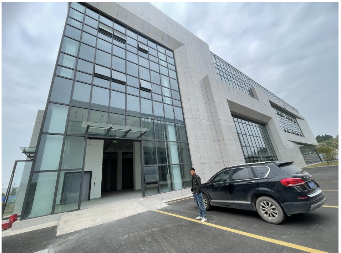
厂房外部照片
