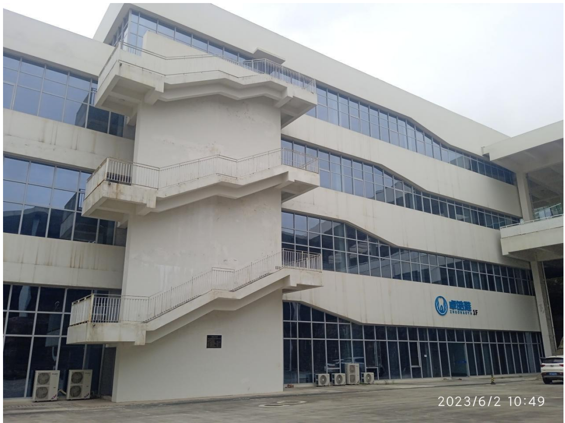
厂房外部照片
