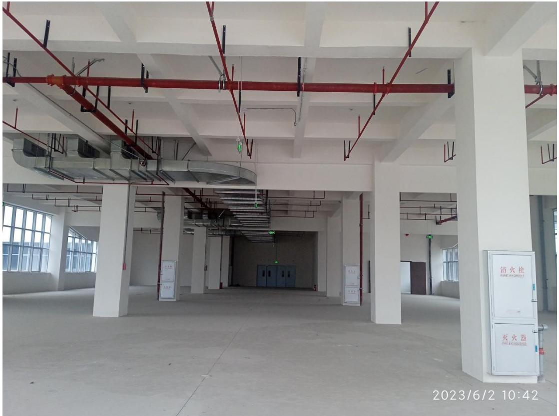
厂房内部照片
