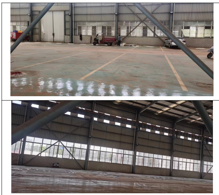
图 2-4 项目厂区现场图
