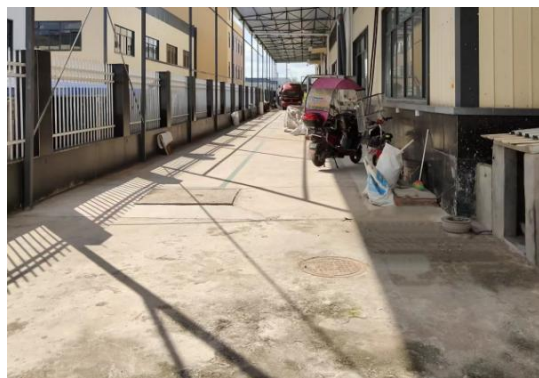
已建化粪池地面
