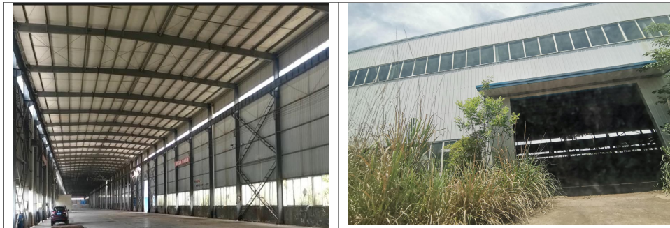
生产车间现状
