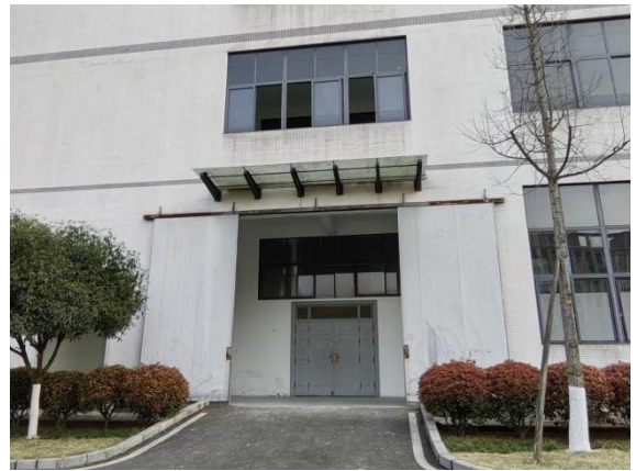
厂房外部照片
