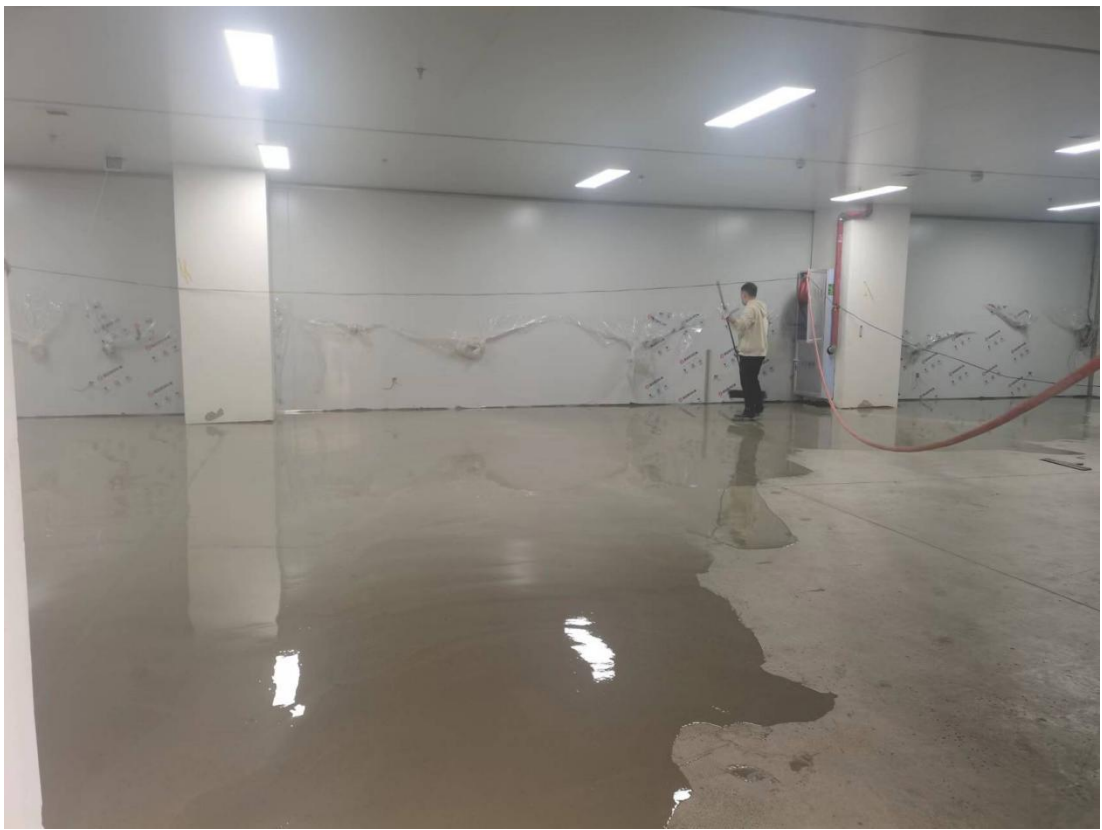
厂房内部照片
