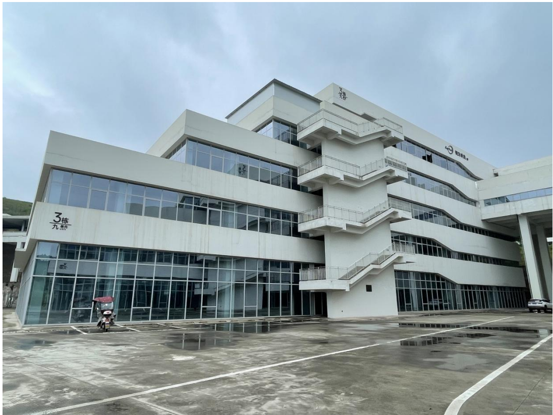
厂房外部照片
