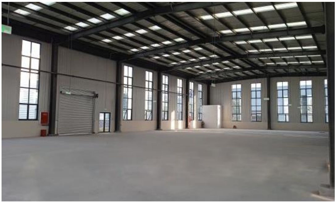
厂房内部照片
