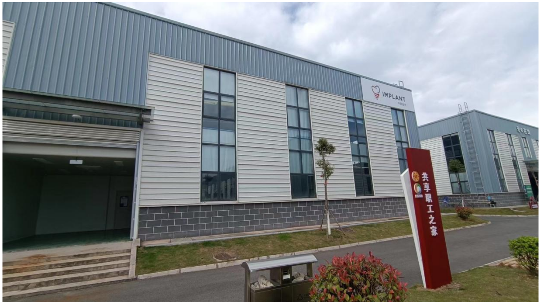
厂房外部照片
